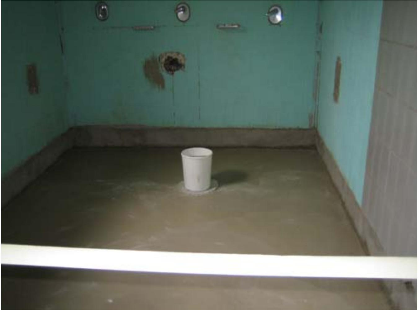
Zur Zeit werden die Duschen am Mennersberg komplett renoviert. Die alten Duschen waren im wahrsten Sinne nicht ganz dicht. Dh. es wird auch der Fußboden komplett neu aufgebaut, mit Fußbodenheizung. Der Estrich wird so verlegt, damit das Wasser nun besser abfließen kann. Alles wird neu gefliest und auch die Umkleiden werden neu gestrichen. (Stand 5.1.08 - Fußbodenheizung und Estrich sind drin!)
